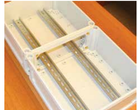
Aplique os parafusos, as porcas e os guias DIN Instalar los tornillos, tuercas y guías DIN
