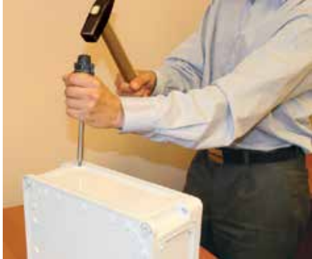
Retire as partes encaixáveis dos furos de montagem Cortar la pared de la tapa retroquelada
