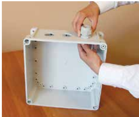
Monte os conectores do condute Instalar el racord o prensa
