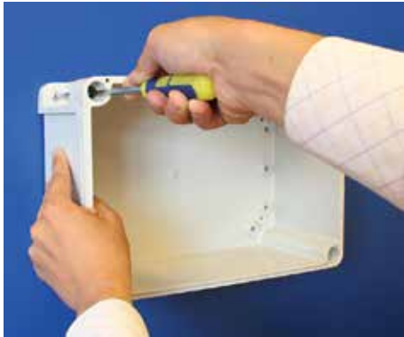
Monte a caixa na parede Fijar la caja a pared
