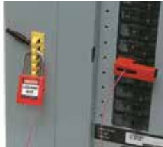
3. Pase la llave de plástico a través de el riel para bloqueo y coloque el candado, evitando que la llave se deslice hacia abajo y que se abra el dispositivo.
