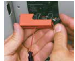
2. Coloque el dispositivo de bloque en el interruptor y póngalo en posición de bloqueo.
