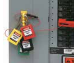
4. Para bloqueos grupales, corra la llave en múltiples aros en el riel de bloqueo y aplique los candados. No se requieren broches. (No se recomienda para uso con broches de bloqueo múltiple)
